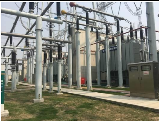
站内已建主变及主变防火墙
