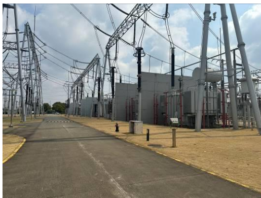
站内已建主变及主变防火墙
